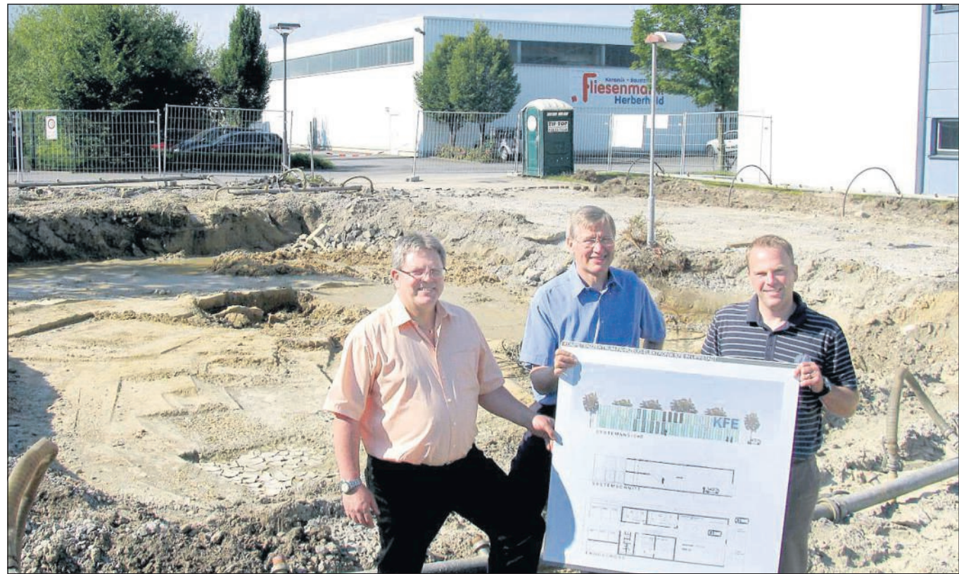
Zwischen dem Cartec-Gebäude (rechts im Bild) und der Firma Otten haben die Bauarbeiten für das KFE begonnen. Die Pläne zeigen hier (v.l.) Cartec-Geschäftsführer Ulrich Dornau, Wirtschaftsförderer Wilhelm Coprian und KFE-Mitarbeiter Carsten Wiesemann-Hesse.
